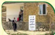
احداث واحد مسکونی
